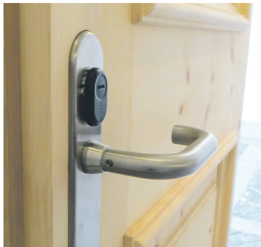
Kaba c-lever mit selbstverriegelndem Dreipunktschloss am Haupteingang eines Mehrfamilienhauses in Zuoz.
