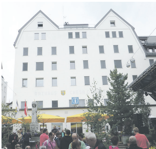
Die elektronische Schliessanlage im Rathaus St. Moritz kann flexibel an Organisationsänderungen angepasst werden.
